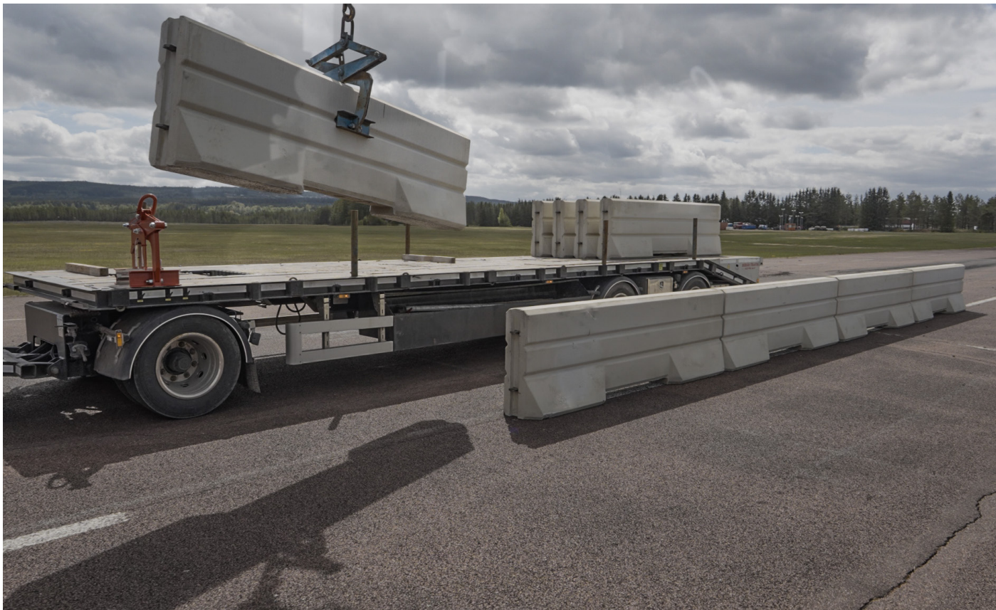
För snabba och säkra lyft av GPLINK rekommenderas lyftsax avsedd för ändamålet. Saxen placeras centriskt i den översta rillan på elementet.
