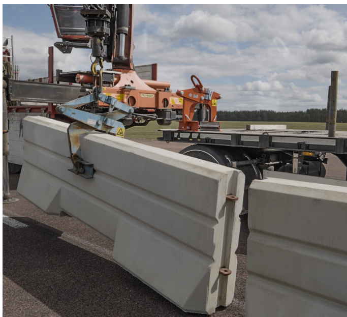
Första elementet placeras med grå (låg) skarvtungor i monteringsriktningen. Nästa element placeras med de röda (hög) tungorna över de grå.
