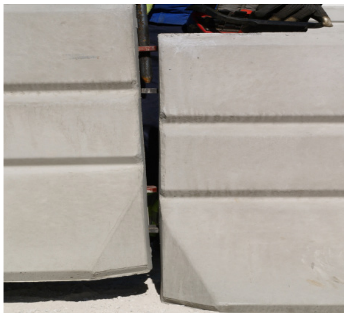
Skarvpinnen lyfts upp ur det monteringsfärdiga elementet. Elementet lyfts till rätt läge. Skarvpinnen placeras lodrätt genom alla fyra tungor.
